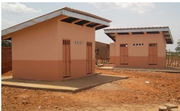
Figure 1 : Blocs de latrines au sein d'une école
