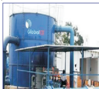
Photo 3.2: Site de production d'eau potable près du lac de Sonfonia
